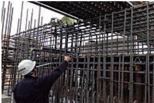
鉄筋径・本数・ピッチ確認状況
