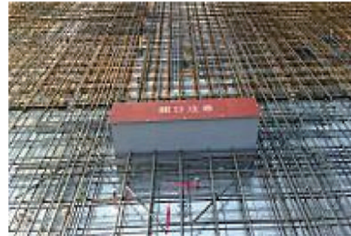
開口補強筋等確認
