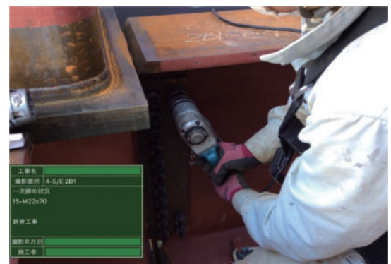
トルシア形高力ボルト一時締め状況
